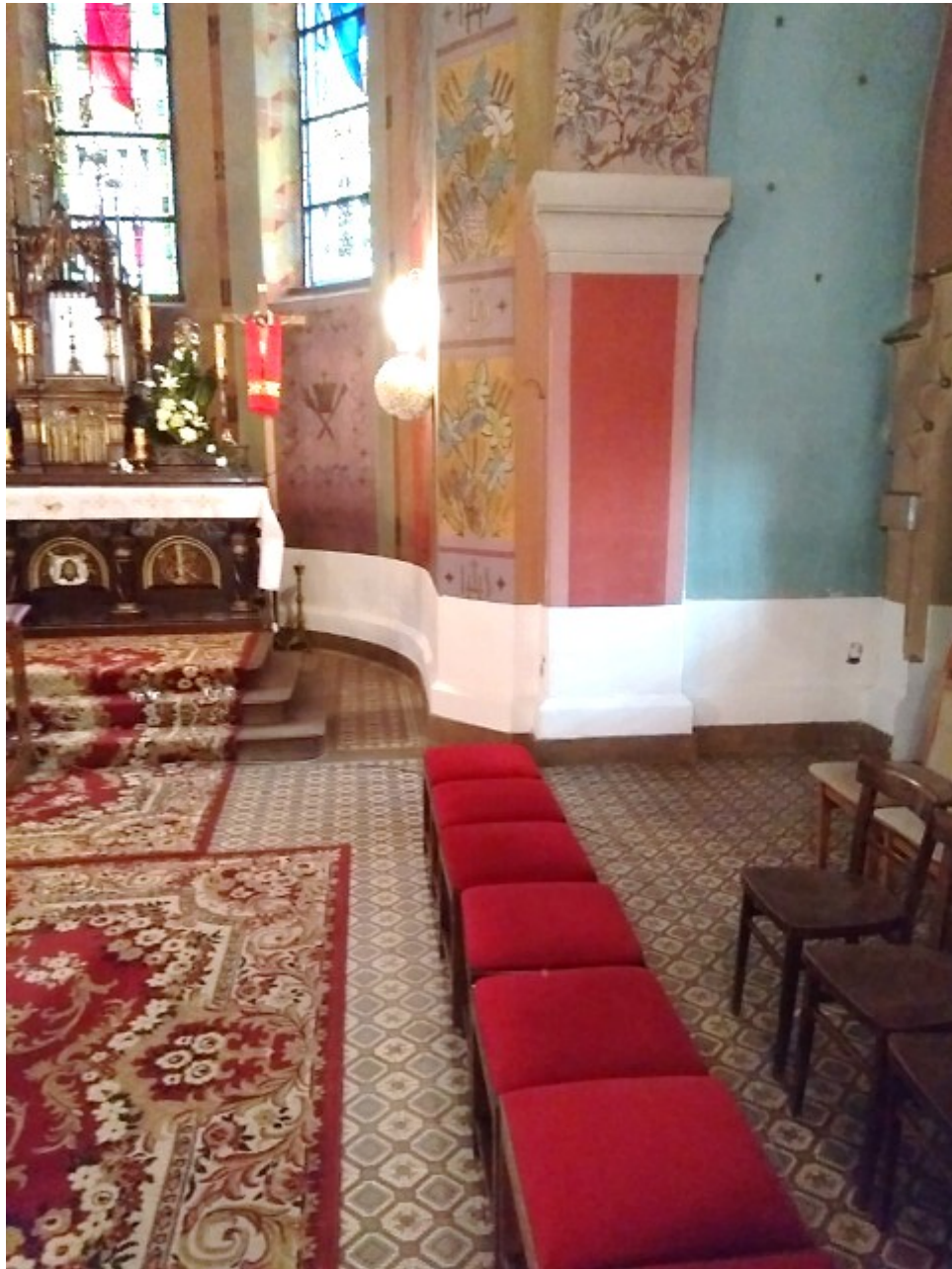
10. Wnętrze kościoła pw. św. Apostołów Piotra i Pawła w Porębie Radlnej - prezbiterium strona pd. z wymienionym pasem tynków po wykonanej izolacji poziomej
