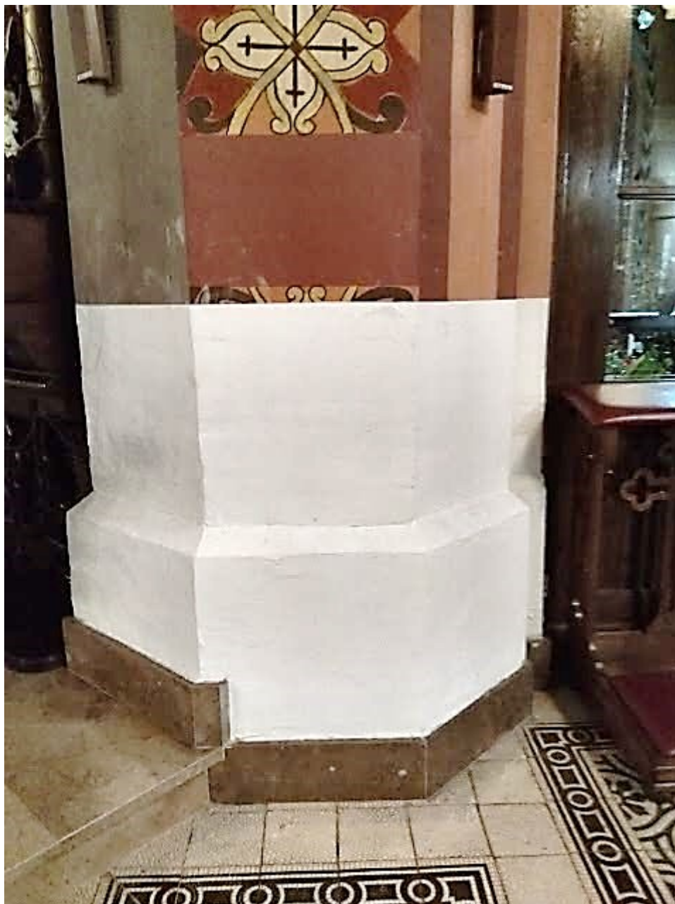
11. Wnętrze kościoła pw. św. Apostołów Piotra i Pawła w Porębie Radnej - filar, w przejściu z nawy do transeptu (strona pd.) z wymienionym pasem tynków po wykonanej izolacji poziomej
